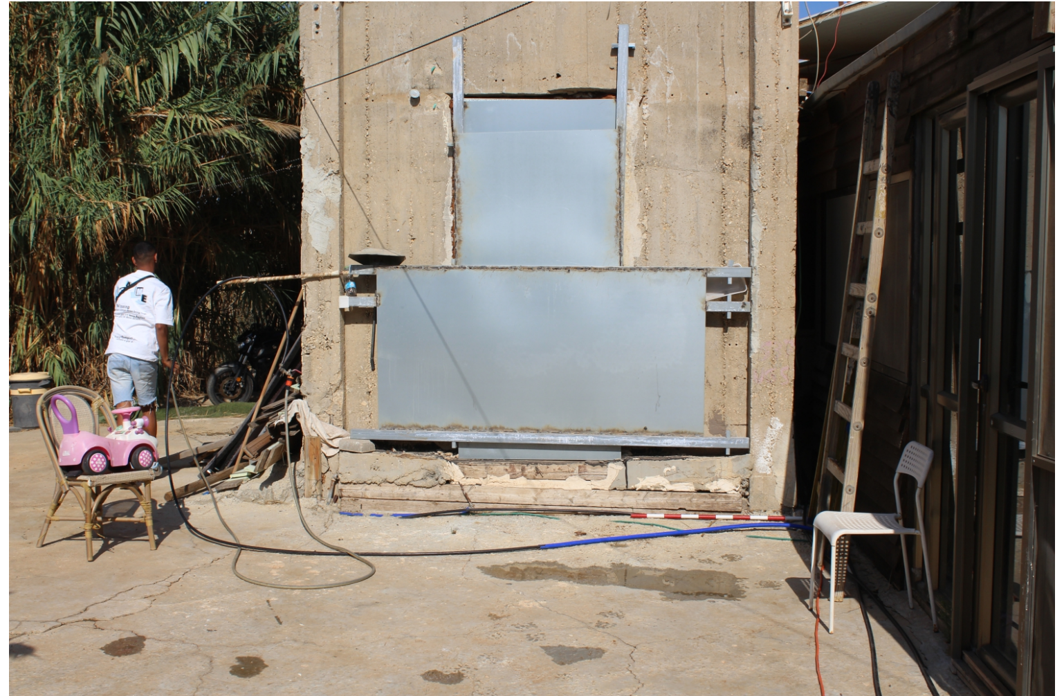
מבט צפונה. קיר דרומי. פתח כניסה חסום עם קונסטרוקציית מתחת ע"י עיריית רשל"צ. בבסיס של המבנה בצד ימין סרגל מדידה בקנה מידה 1 מטר.
